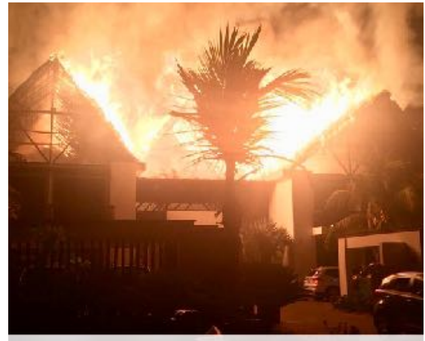
INCENDIO PROVOCADO POR FUEGOS ARTIFICIALES
