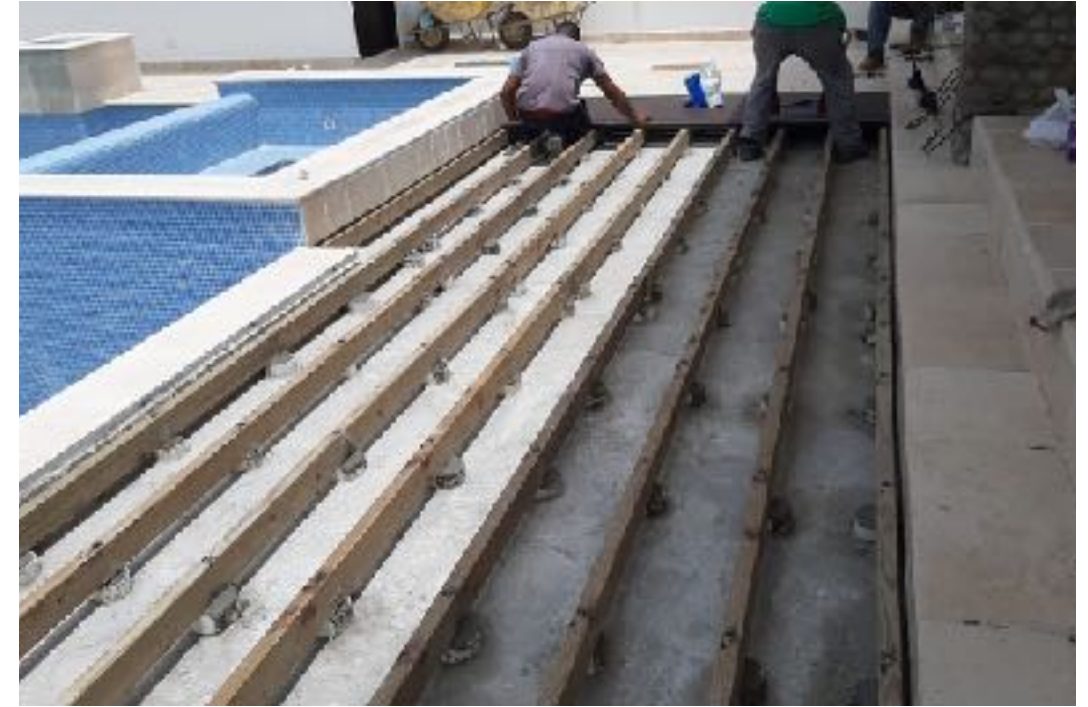
SUBBASE SOBRE CONCRETO
