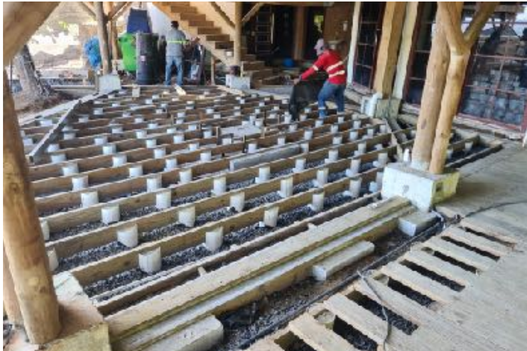
SUBBASE SOBRE TIERRA O ARENA
