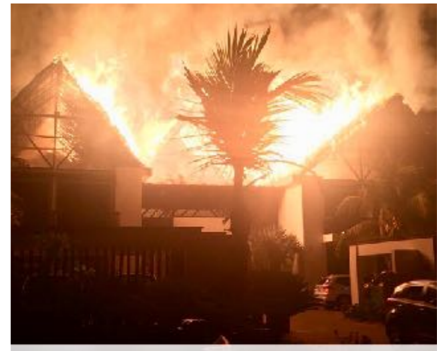
INCENDIO PROVOCADO POR FUEGOS ARTIFICIALES
